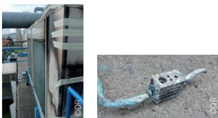
La mauvaise connexion électrique du câble d'alimentation de 16 mm<sup>2</sup> a entraîné un échauffement du boîtier de dérivation, jusqu'à ce que le fil se sépare et déclenche un incendie. Pour éviter ce type d'incident, les professionnels doivent s'assurer de la bonne connexion du câble d'alimentation.
