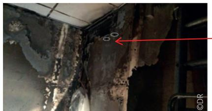
Le raccordement (non-protégé par un disjoncteur spécifique) de la pompe de relevage directement à l'alimentation électrique principale de l'unité intérieure a provoqué l'incendie.
