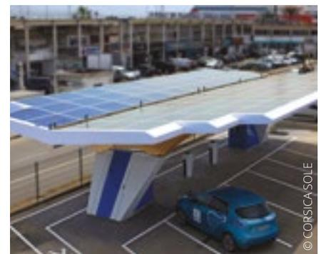
Ombrière publique installée à Ajaccio (Corse), depuis mai 2016, qui alimente en autoconsommation huit bornes de recharge. Grâce à une autre ombrière de ce type installée à Bastia, il est possible de traverser la Corse avec de l'énergie 100 % solaire. La même technologie a déjà été déployée sur quatre autres installations en France à Perpignan, Vénissieux, Bastia et Béthune-Bruay.
